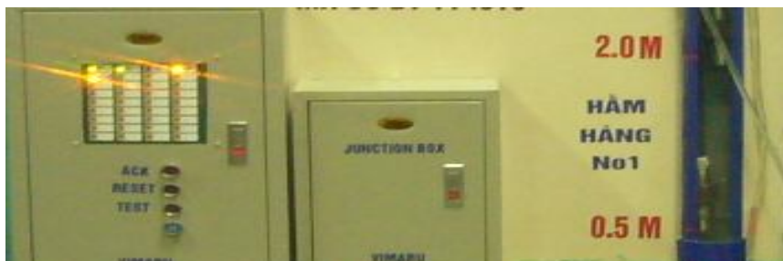
Hình 2. Thử nghiệm hoạt động của cảm biến báo động nước.
