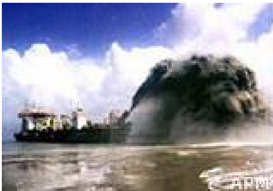
Hình 1: Tàu hút phun cát san lấp tạo bãi
