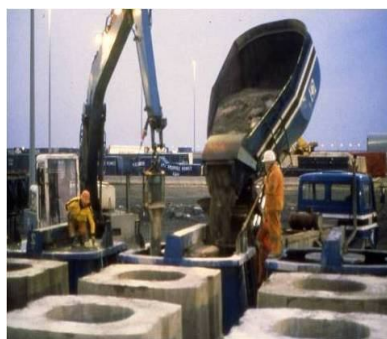
Đổ bê tông
