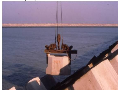
Hình 10. Lắp đặt khối Haro trên mái dốc với phương tiện thi công đơn giản.
