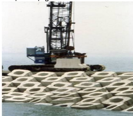
Hình 10. Lắp đặt khối Haro trên mái dốc với phương tiện thi công đơn giản.
