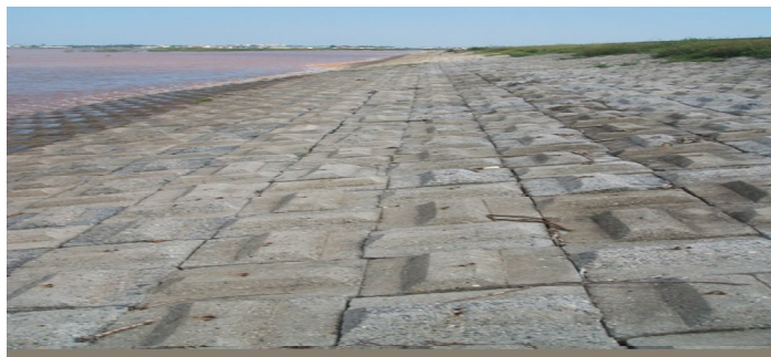
Hình 1. Kè bê tông tấm âm - dạng hình vuông có mô giảm sóng.
