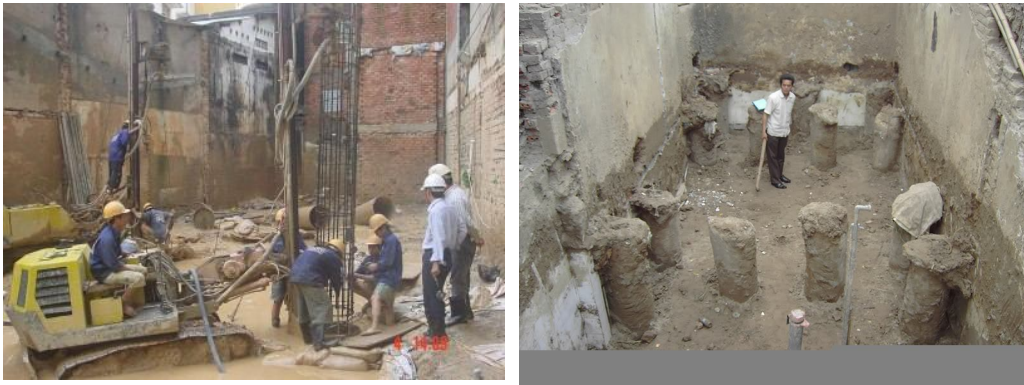
Hình 2. Thi công cọc nhỏ tiết diện nhỏ.
