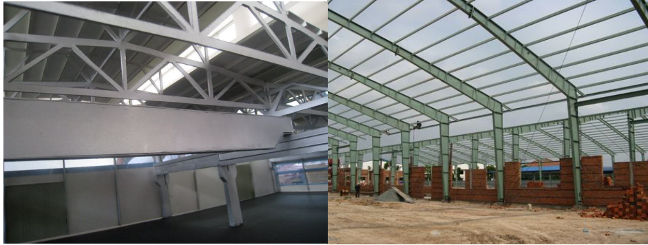
Hình 1. Các loại nhà công nghiệp bằng thép. a) Nhà có cầu trục; b) Nhà không có cầu trục
