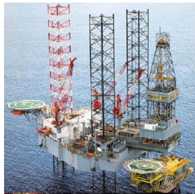
Hình 1.5. Kết cấu chân đế kiểu giàn.
