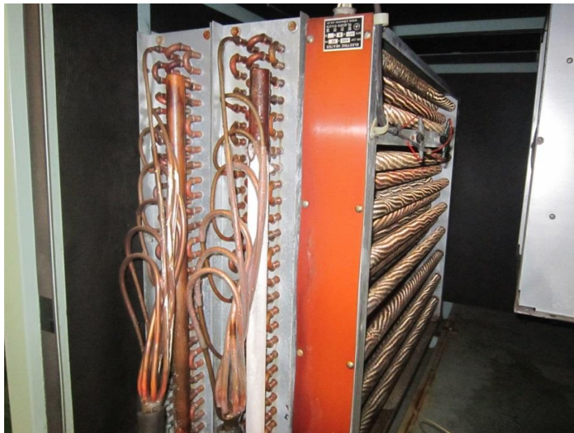
Hình 2.8. Dàn bay hơi và dàn sưởi trong hệ thống
