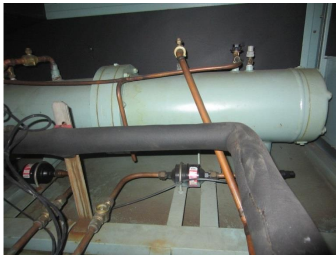
Hình 2.6. Bình ngưng trong hệ thống
