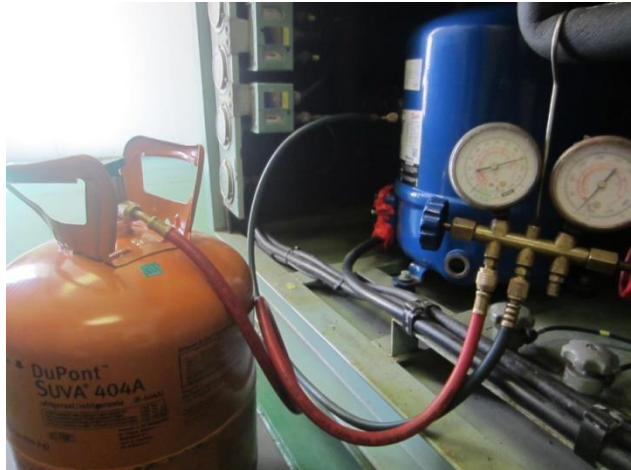
Hình 2.11. Quá trình thay thế công chất R404A cho hệ thống
