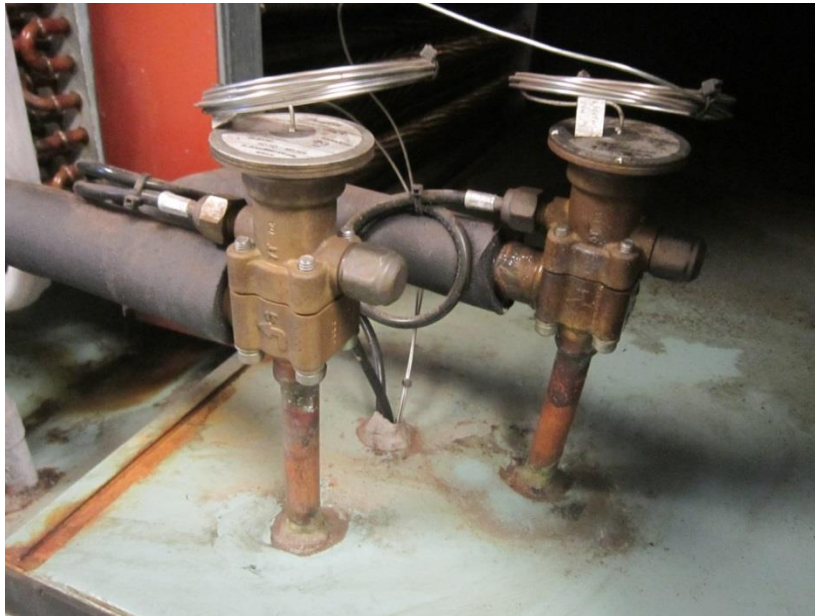
Hình 2.9. Van tiết lưu trong hệ thống
