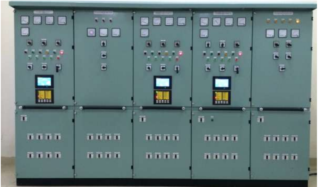
Hình 1.2 Tổng quan mặt trước các Panel hệ thống mô phỏng bảng điện chính
