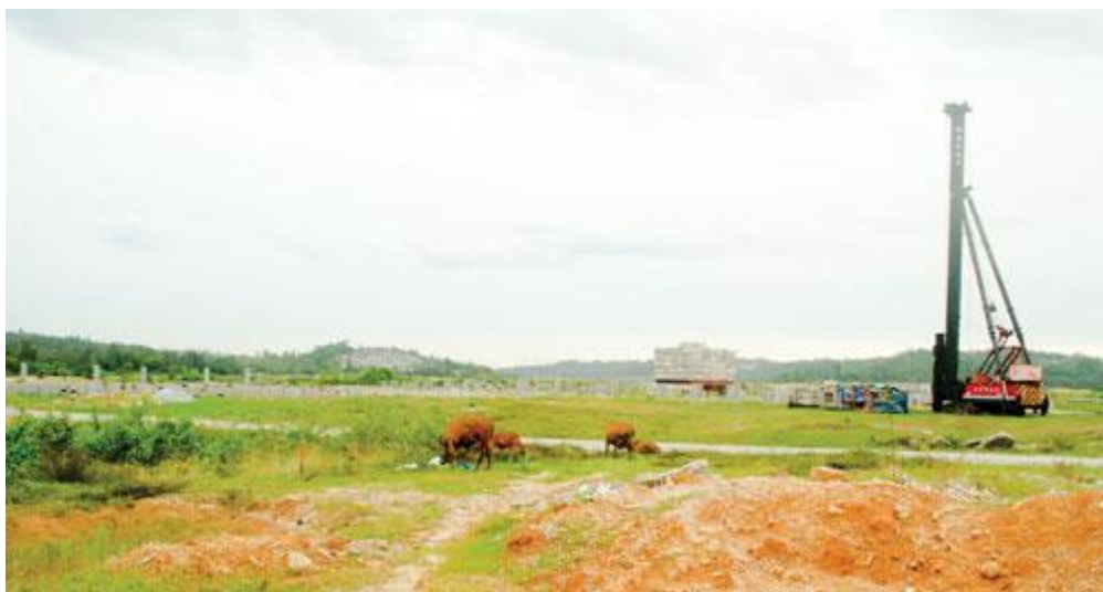
Hình 1.8: Sau 6 năm khởi công, dự án thép Dung Quất vẫn là bãi đất trống mênh mông.
