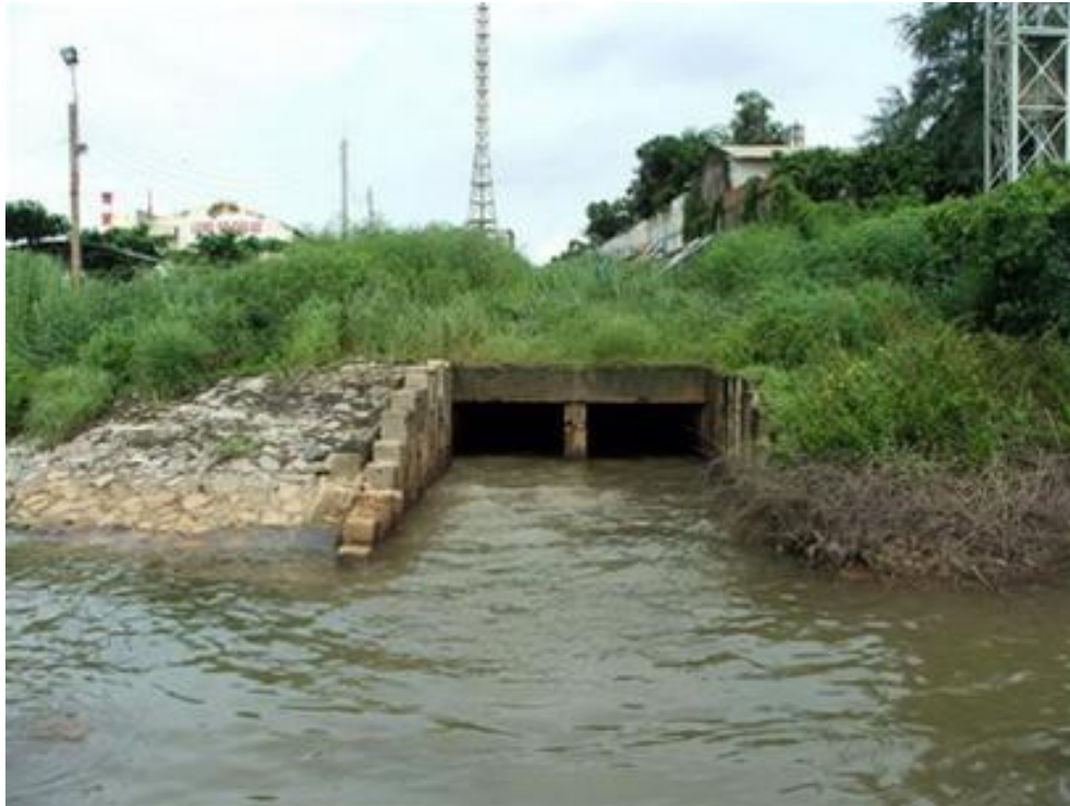
Hình 1.10 Cống xả nước thải từ nhà máy Vedan ra sông Thị Vải.
