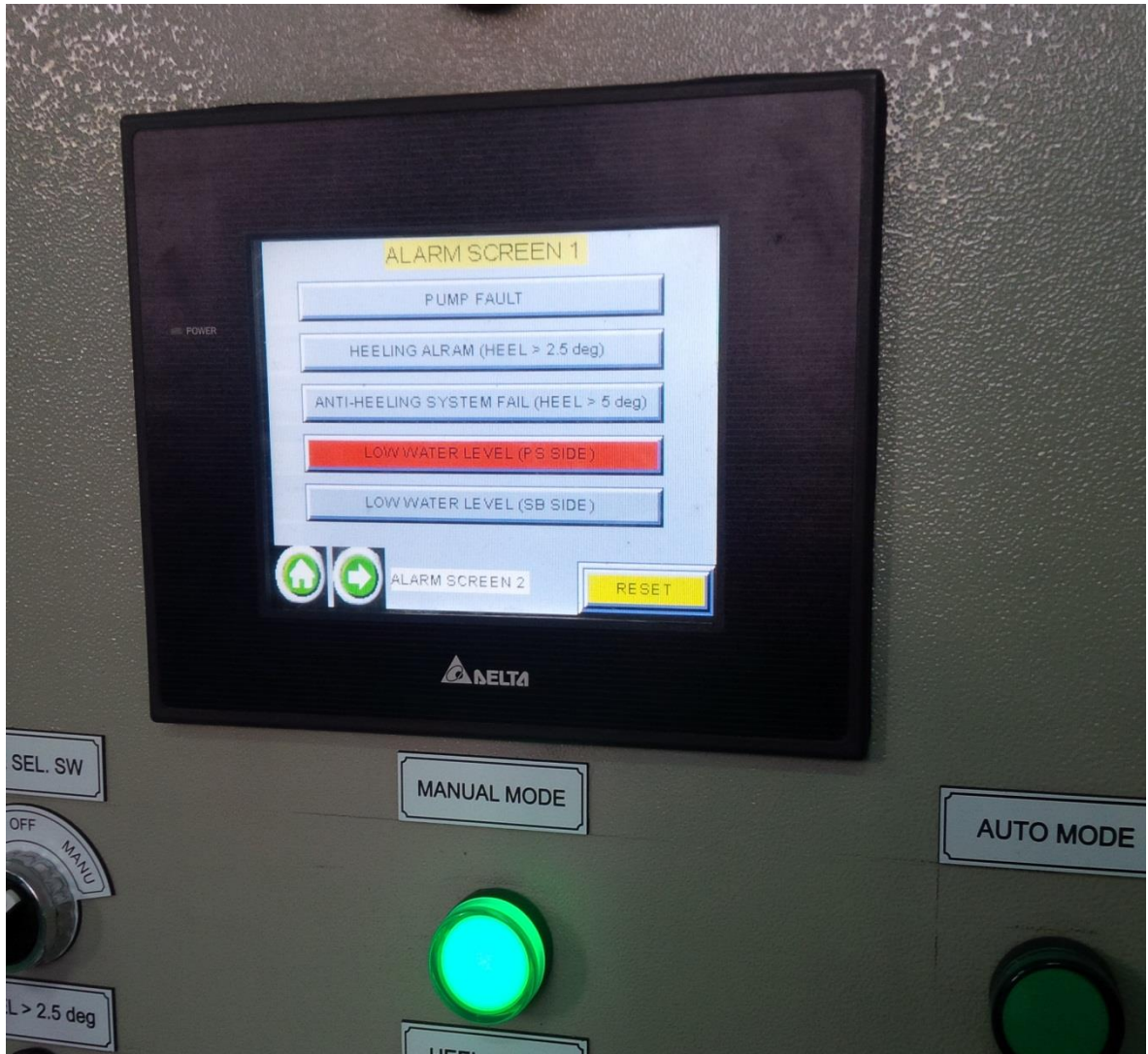
Hình 3.24 Thử nghiệm hệ thống báo động bảo vệ
