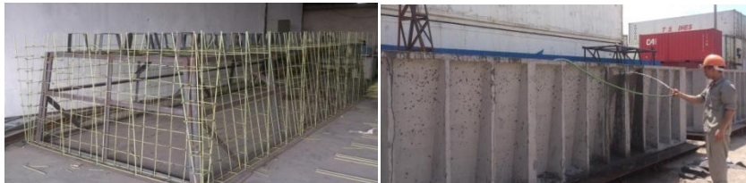
Hình 1. Khối bê tông cốt sợi thành mỏng đúc sẵn
