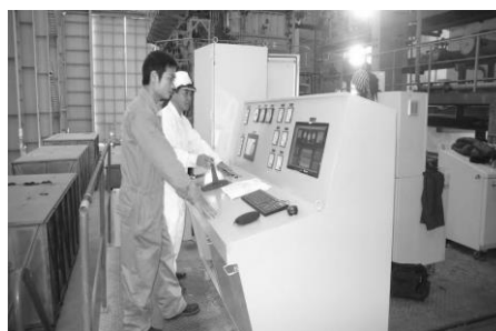
Hình 2.6. Thử hệ thống điều khiển tại xưởng
