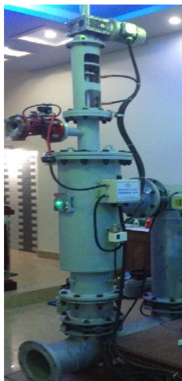
Hình 1. Hệ thống điều khiển bầu lọc rửa tự động được thiết kế lắp trong hệ thống xử lý nước dằn tàu
