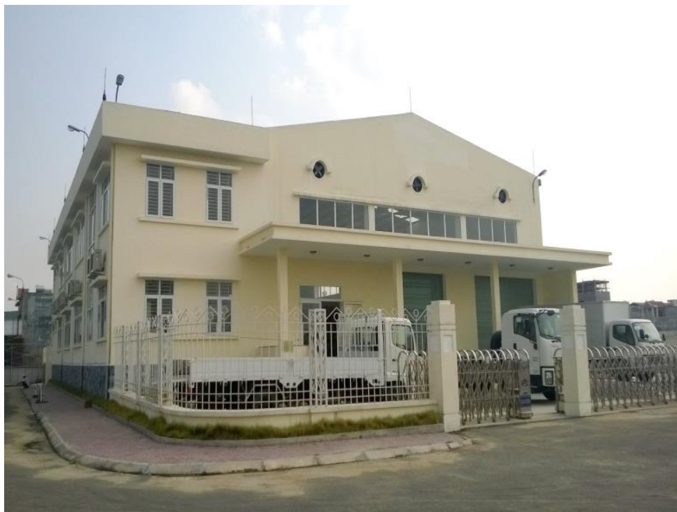
Hình 4. Toàn cảnh khối nhà phục vụ công tác đào tạo
